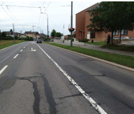
Route de Lausanne très large devant le bâtiment de l'administration communale
