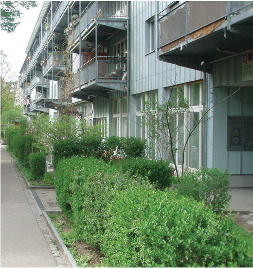
L'espace privé devant le bâtiment est une surface appropriable: jardinet résidentiels, terrasses, espace d'entrée aux commerces et logements
