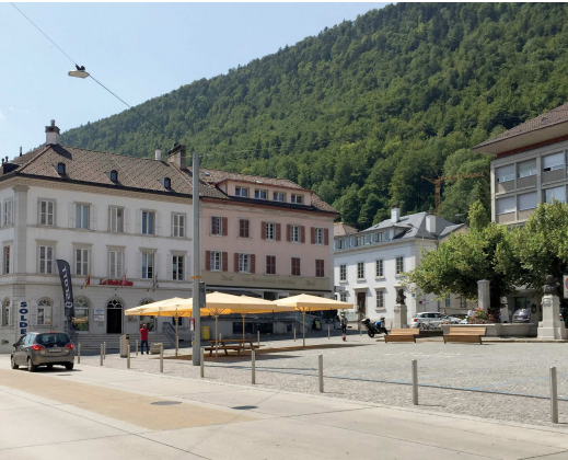
Traversée de la place avec bande centrale polyvalente (Saint-Imier, BE)
