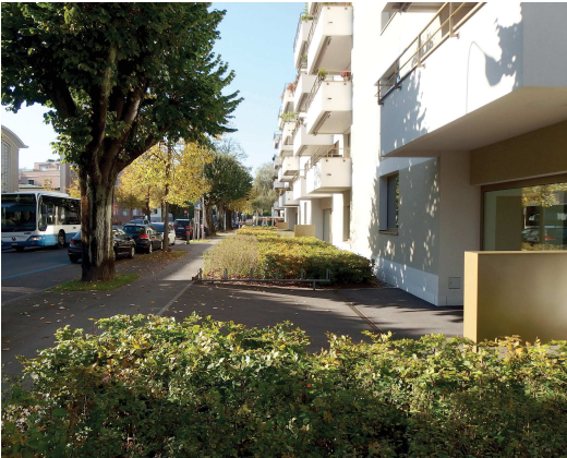
Rez-de-chaussée à vocation résidentielle avec jardinets privés, agissant comme un filtre vis-à-vis de l'espace public (Fellenbergstrasse, ZH)
