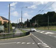
Discontinuité du parcours (barrière de sécurité) à la hauteur de l'école enfantine
