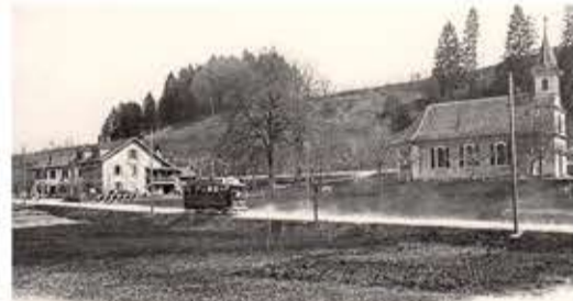
Le Mont sur Lausanne. Eglise du Mont-sur-Lausanne et tram, non datée. Ouverture visuelle sur l'église, lien avec la route cantonale. Espace dégagé autour de l'église ainsi mise en valeur.
