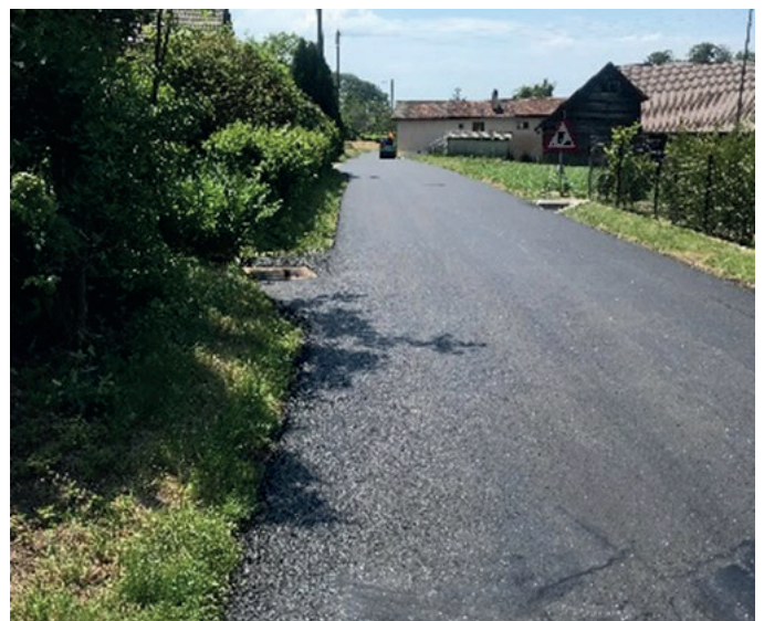
Aspect final de la route après réfection de la chaussée.
