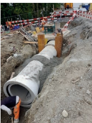
Nouvelle chambre et pose de canalisations.
