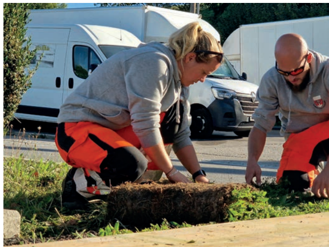
Pose de rouleaux prêts à planter.
