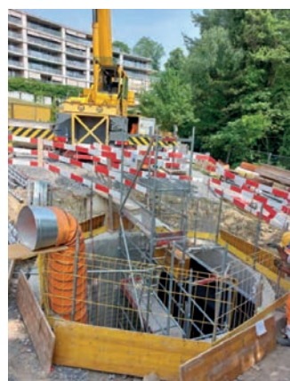
Nouvelle chambre et pose de canalisations.
