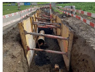
Enrochement et travaux pour la pose de canalisations.
