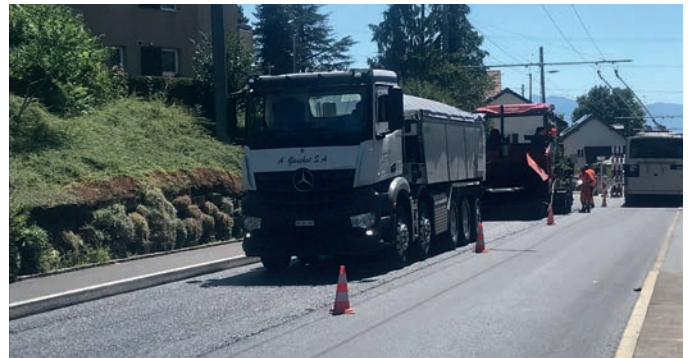
Travaux de réfection à la route de Lausanne.
