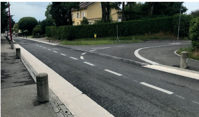
Aménagements réalisés au chemin des Martines.
