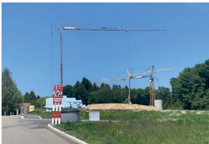
Grues de chantiers - chemin du Bois de l'Hôpital.
