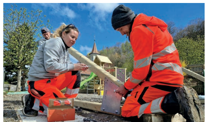
Montage de la balançoire de la place de jeux de Coppoz.
