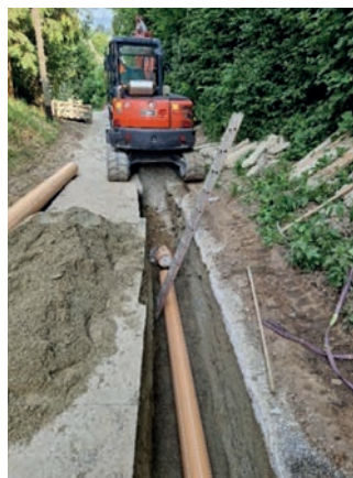
Travaux de pose de canalisation et aspect final de la route après réfection de la chaussée.
