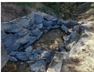
Enrochement et travaux pour la pose de canalisations.
