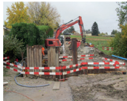
Excavation de la fouille pour la pose des collecteurs.
