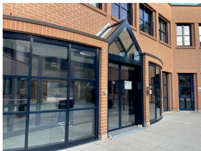
Sas d'entrée de l'administration en cours de rénovation.
