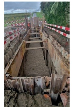
Excavation de la fouille pour la pose des collecteurs.
