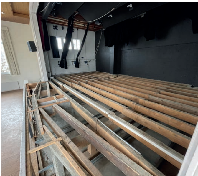
Rénovation de la scène de la Grande salle du Petit-Mont.
