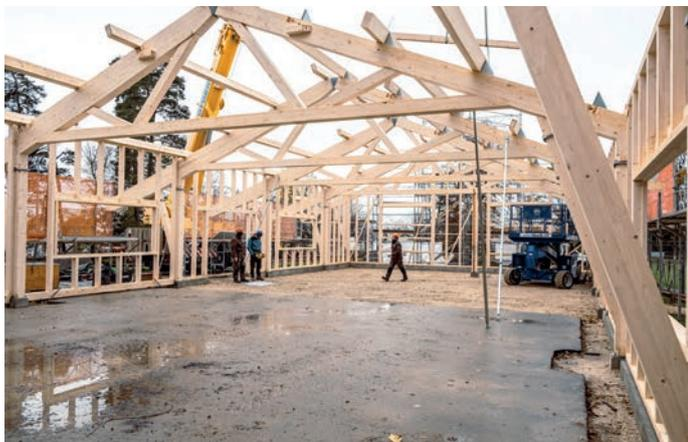
Cette nouvelle cantine, de construction simple et fonctionnelle, non chauffée, réalisée en grande partie en bois de la commune avec un sol en bitume, comprend 310 m<sup>2</sup> de surface intérieure et pourra accueillir environ 295 personnes assises. De grands vitrages en façade amèneront de la clarté en journée et un avant-toit conséquent permettra l'installation de tables en extérieur et à l'abri des intempéries.
