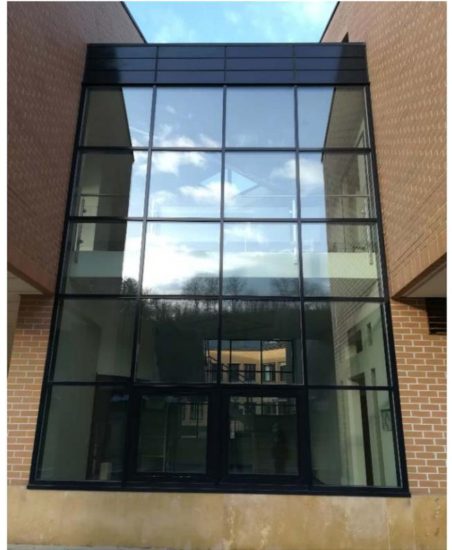
**SAS D'ENTRÉE:** remplacement des deux baies vitrées latérales de l'entrée principale, qui étaient d'origine. Les profils métalliques inférieurs sont entièrement corrodés à cause de l'entretien hivernal sur le long terme.
