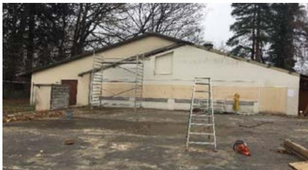
La partie bois de la cantine présente une dégradation avancée dans sa structure porteuse. Une première expertise en 2012 révèle des déformations et la pose de renforts par le charpentier consolide les fermes de la charpente. La pose de témoins permet le contrôle des déformations admissibles. Le rhabillage des solives assainit le plancher dans la partie appelée Pont de danse.
