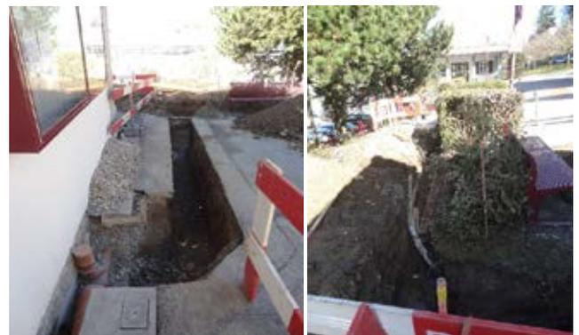
Pose des nouvelles conduites de canalisations, vues sur les fouilles en cours de travaux
