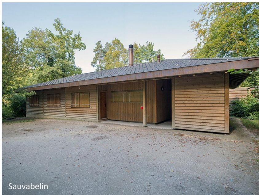
Ce type de construction est plus moderne et  labor  en amont en atelier. Fabriqu    l'ext rieur, son montage est relativement rapide et accessible   plus d'entreprises de la fili re en mati re de construction en bois. Les ext rieurs pourraient  tre am nag s en collaboration avec le CFPF.
