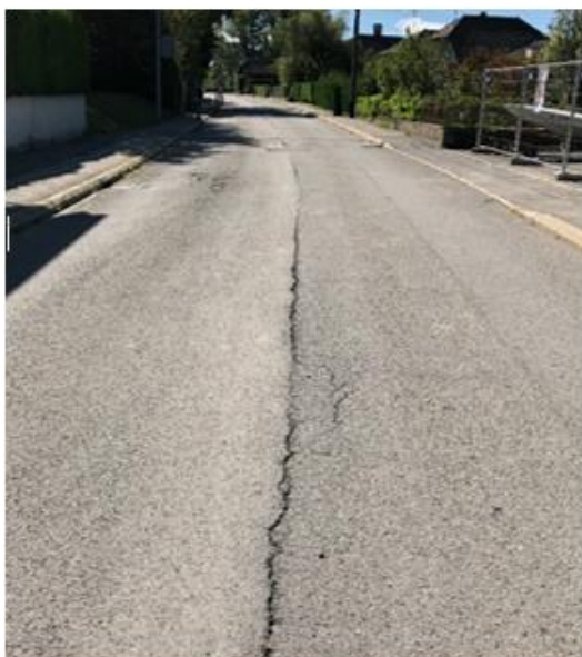
Fissure longitudinale
