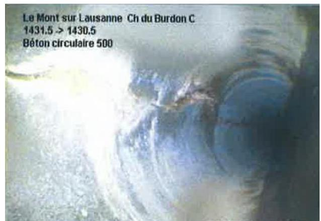
Fissure longitudinale avec écrasement du tuyau des eaux claires
