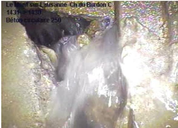
Liaison et tuyau cassés avec infiltration d'eau dans les eaux usées
