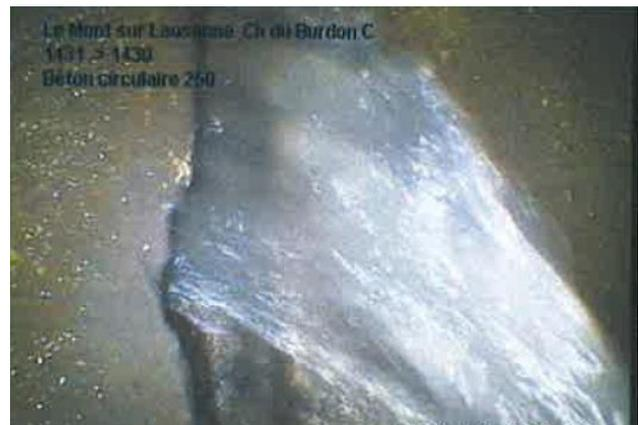
Importante infiltration d'eau à travers jointure ouverte dans les eaux usées
