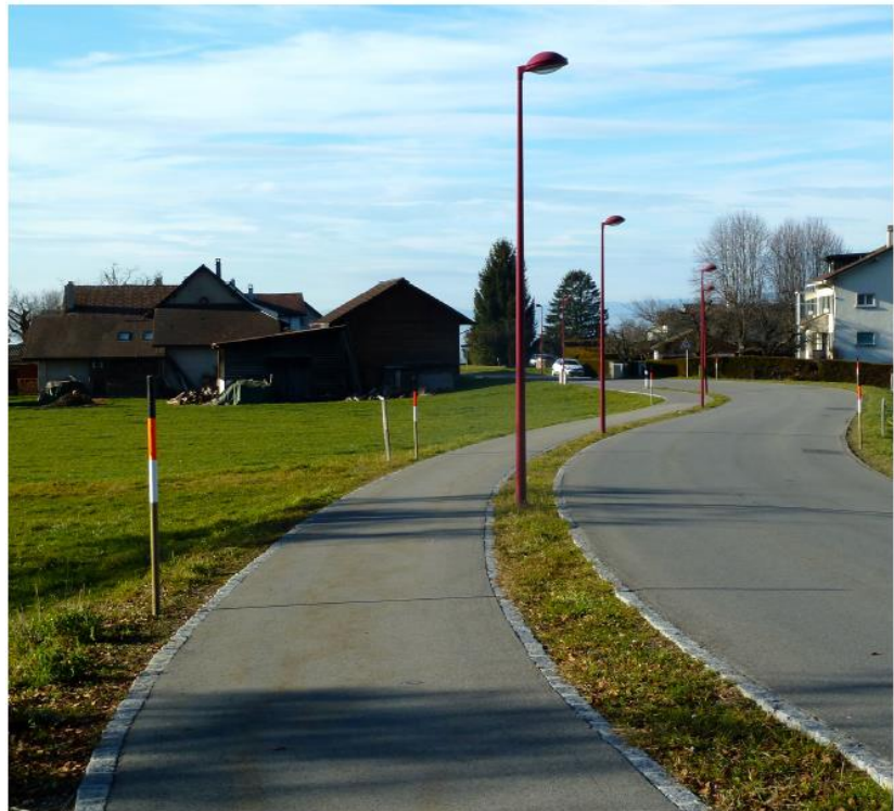
Figure 4 : Exemple de réalisation Cheminement combiné en site propre le long de la route du Jorat. (Source photo : SUDD)
