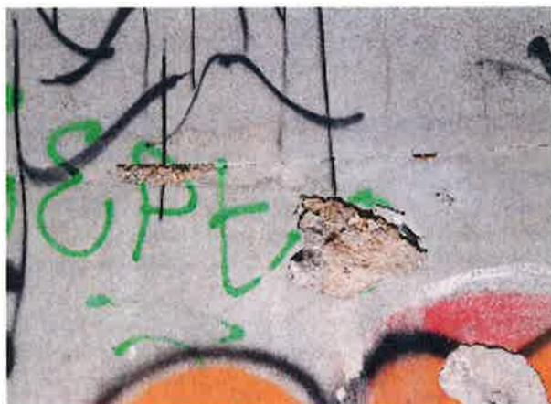
Quelques éclats de béton ont été constatés dans les structures du skate park. Une rénovation lourde, permettant notamment de lisser les surfaces des pistes est prévue au printemps 2019.
