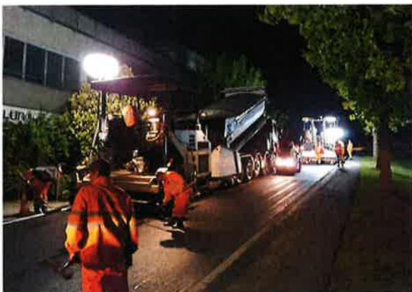
La partie supérieure du chemin de Pernessy a également été réfectionnée, et une nouvelle couche de roulement a été posée après réfection du double rang de pavés délimitant son trottoir.
