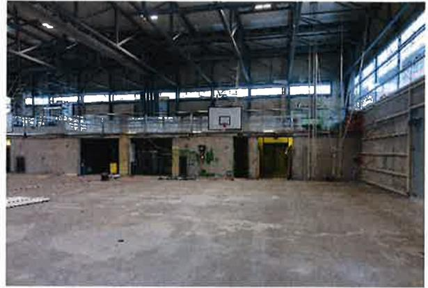
Les principaux travaux ont consisté à remplacer l'enveloppe thermique (toiture, façades, dalles sous terrain) et à changer les installations techniques sous contrat CPE pour optimiser la performance énergétique.
