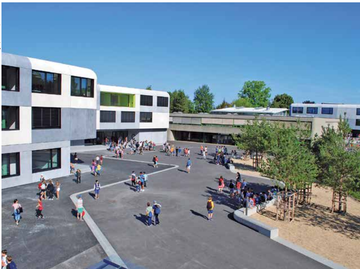
Site scolaire du Mottier.
